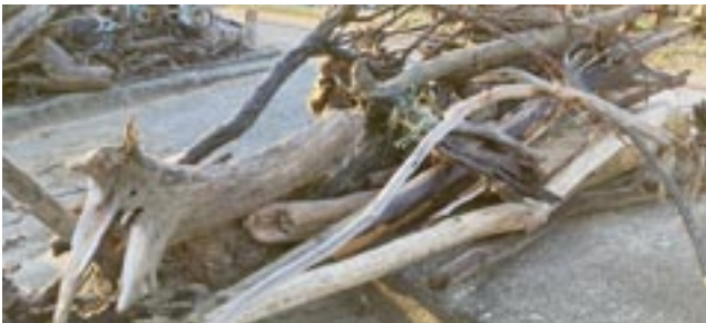
2025 年 10 月 29 日 今日の作業はほとんど流木処理
