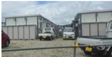
震災の仮設住宅
