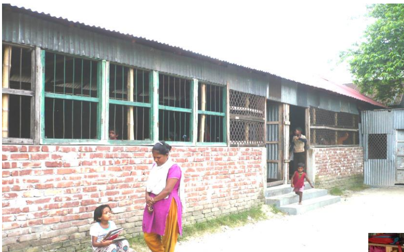
校舎が1棟完成しました。(3棟のうちの1棟)
