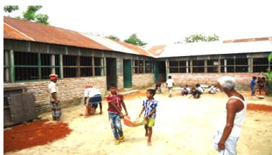
2012年12月にできあがった2棟の校舎
