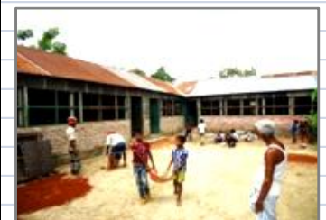
完成間近の2・3棟目の校舎
