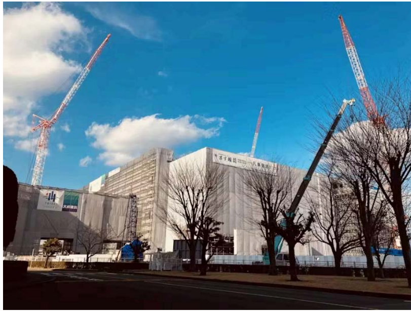
東京エレクトロン九州が建設中の研究開発施設
