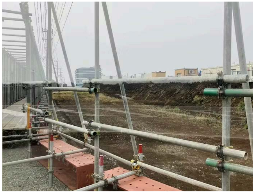
TSMC熊本第2工場の建設予定地
