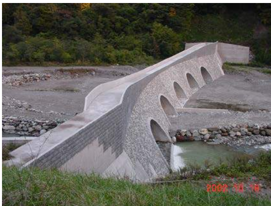
写真2 神通川水系蒲田川に設置された大暗渠砂防堰堤
