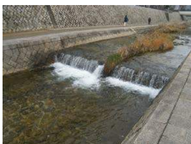
魚道設置前の 15 番目の落差工
