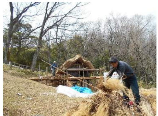
(写真6) 会下山遺跡高床倉庫茅葺き替え
