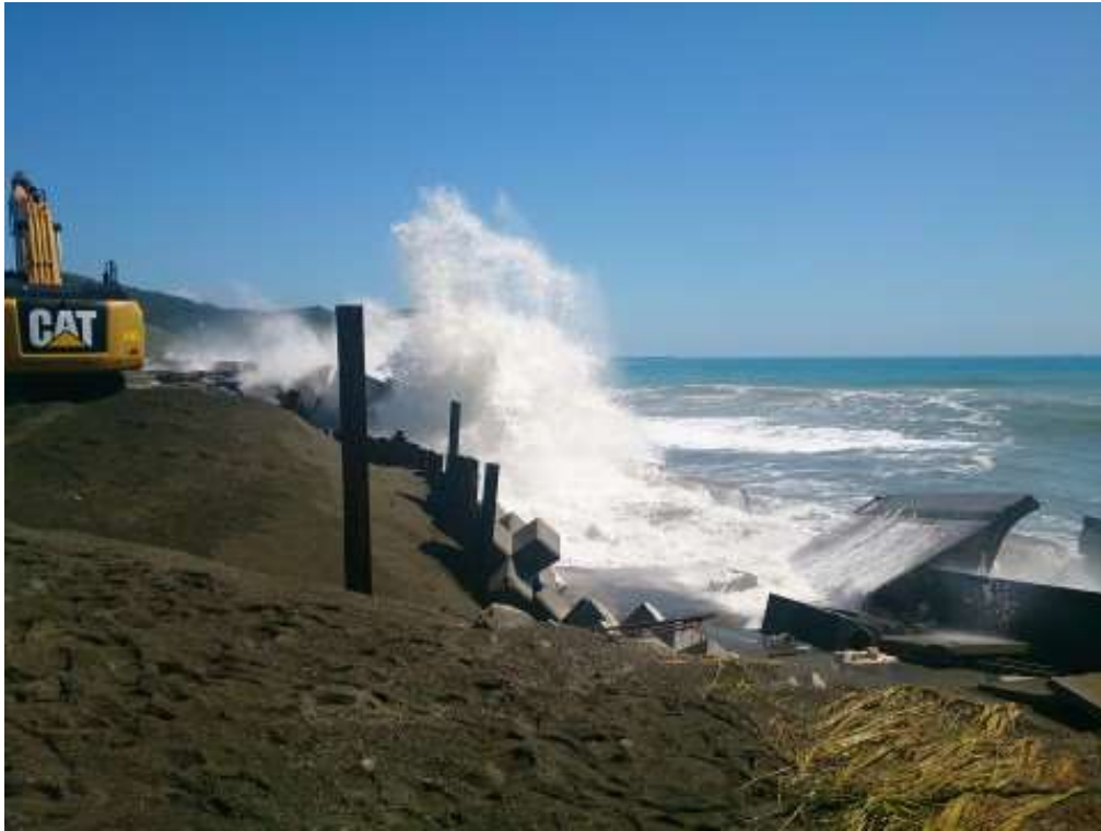
土砂の流失を防ぐための応急工事（ネット画像より）
