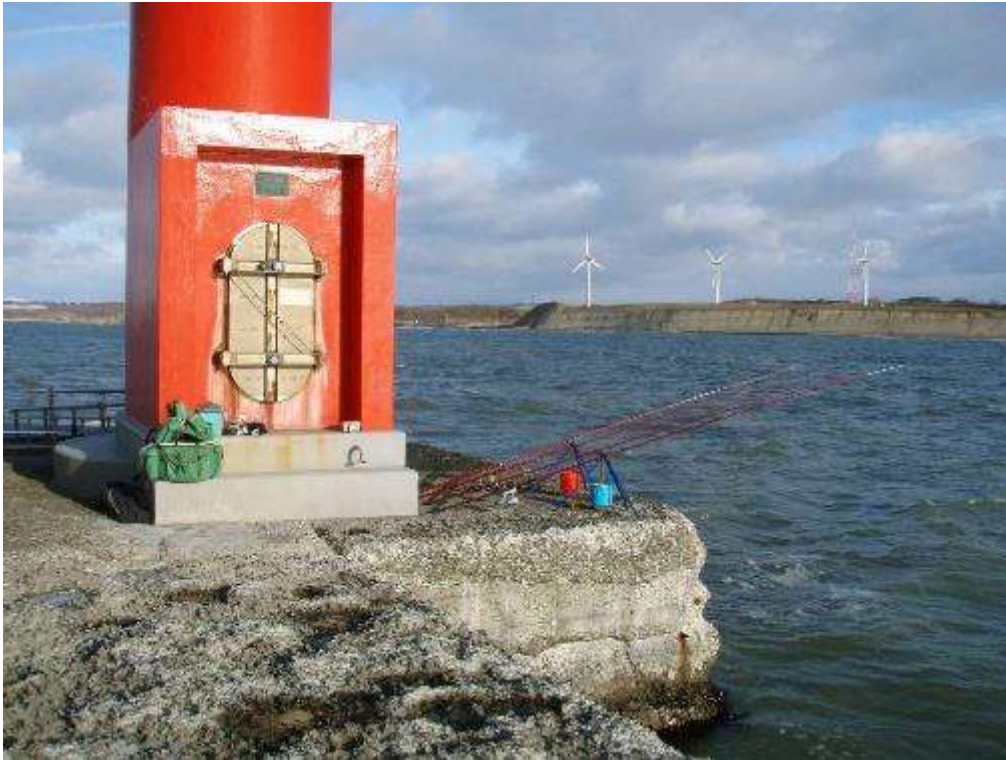
北防波堤先端で竿を出し終えた。事件の後はその手前側で竿を設置した。
