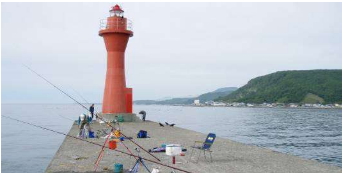
松法漁港外防波堤先端部
