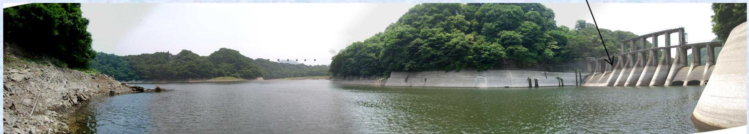
沼本ダムと津久井湖がつながってしまい、堰堤が水没した普段の様子（ダムのHPより引用）
