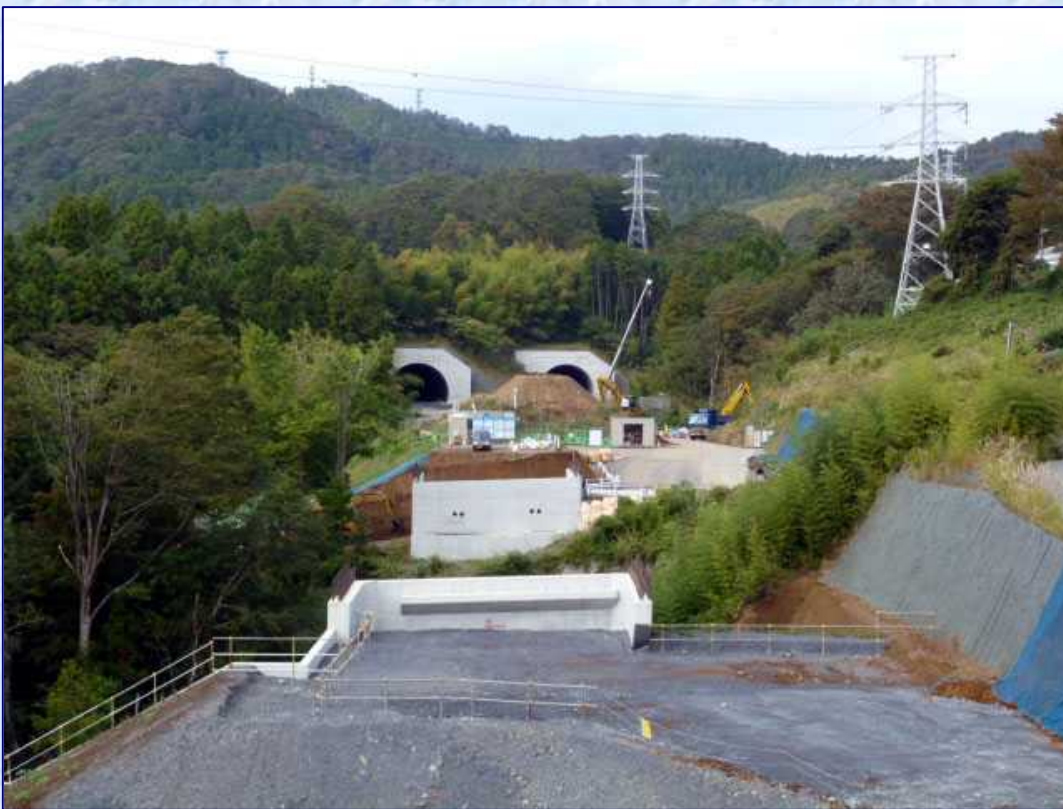
城山湖の真下を避けて高尾山をぶち抜いたトンネルは、もう2本とも抜けており、今は内部の化粧をしているところ、開通が待ち遠しい。
