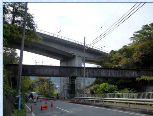
古い水道橋の撤去工事が始まっていた。又一つ、産業遺産が消えていきます。
