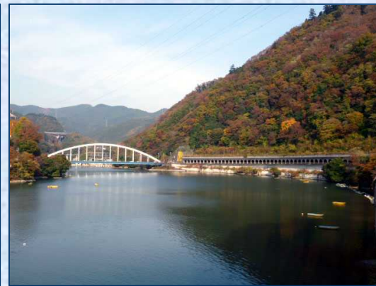
車で過ぎるとあっという間の洞門だが、こうして見ると結構長いです。
