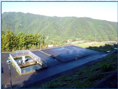
青根浄水場 山腹の浄水場というから口の開いた浄水場かと思いきや、フタのされたプールでした。
