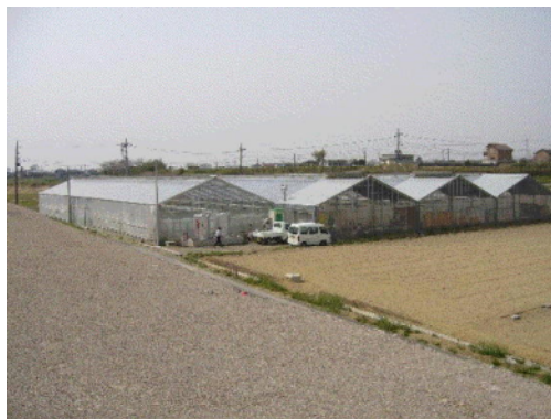
大屋根式フッ素フィルムハウス
