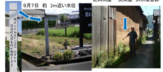
高島 肥料問屋 灰太屋 洪水被害跡
