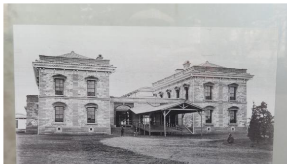
旧新橋停車場の外観
