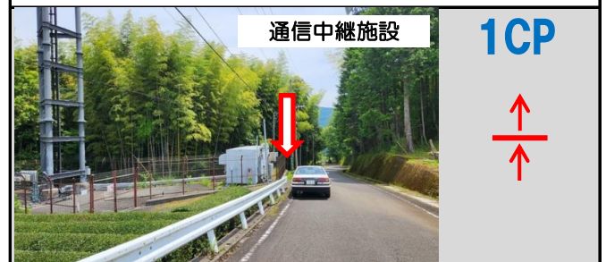
4図先 写真のガードレールの向こう端
