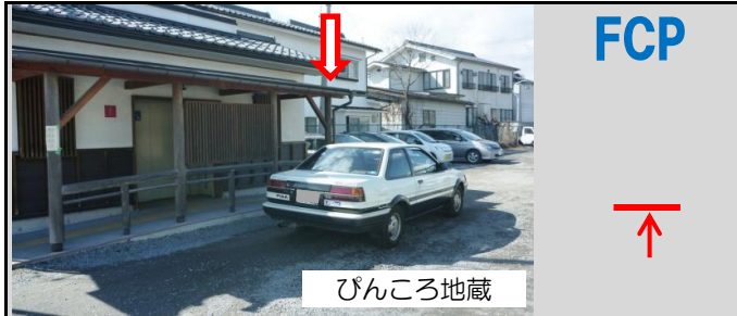
29図 びんころ地蔵駐車場入口にあるトイレの一番奥にある柱 駐車場内は商店名の標示札にかかわらず、どこに停めても良いそうです(山門茶寮ご主人談)
