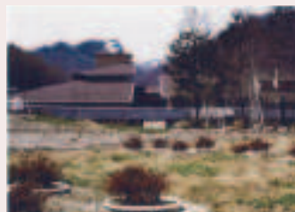
手前の公園のようなところがニイミシステムの浄化槽
