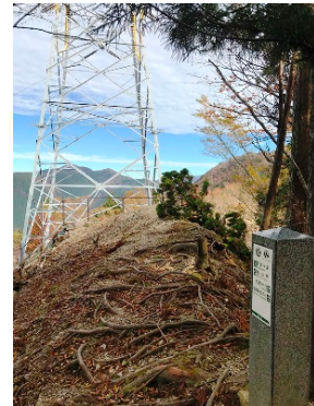
8:59 高圧鉄塔交差点
