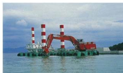
写 2.1-4 バックホウ浚渫の施工状況の例
