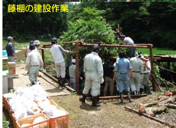
藤棚の建設作業
