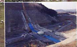
▲建設中の御前山ダム
