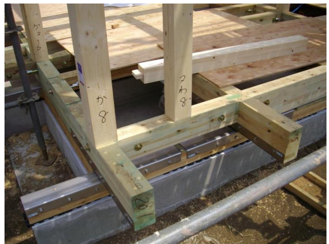
写真 1 従来のすべり支承の設置方法
