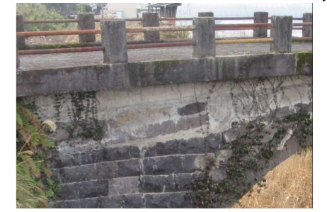
壁石の補修状況
