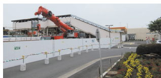
新木駅の橋上化工事の進捗
