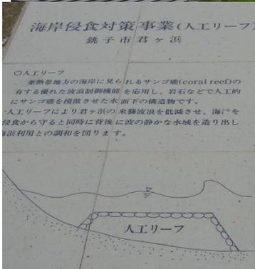
ことで有名な場所でもある。半島の北側に利根川の河口があり、利根川から供給される砂によって、砂浜が 1km にわたって弓なりに続いている。しかし、近年、砂の流出が続き砂浜は往時の半分以下に減少している。砂浜の消失を防ぐ目的で、国交省は砂浜の沖に人工リーフを建設した。人工リーフは、それまでの離岸堤が景観を壊すという意見に配慮して、海面上に姿を見せないように海面下に作った離岸堤である。天然のサンゴ礁を模したと説明板にはある。どの程度、人工リーフが砂の消失に効果があるのかは、不明。(向井宏撮影)
