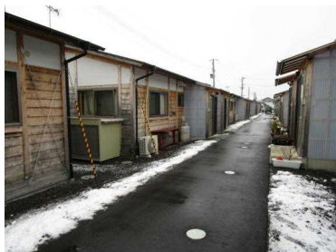
仮設住宅 (福島)
