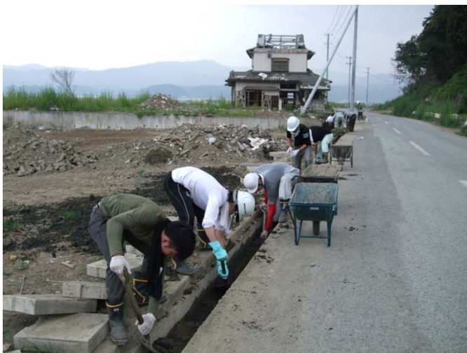
道路側溝の土砂除去
