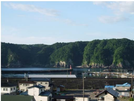
田老町の10mの防波堤
