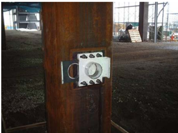
コンクリート圧入口スライドバルブ
