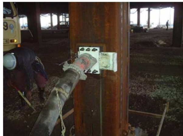
コンクリート圧入口スライドバルブ
