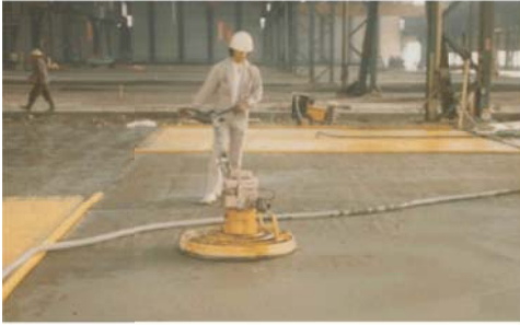
真空コンクリート工法
