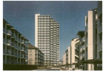
志木ニュータウン高層棟
