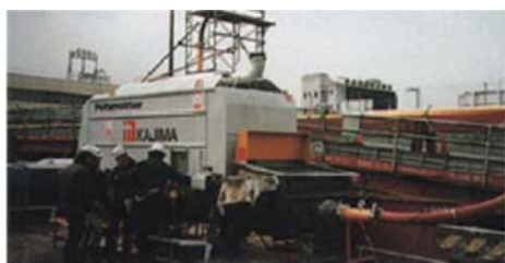
高圧コンクリートポンプ (22N/mm 2 )
