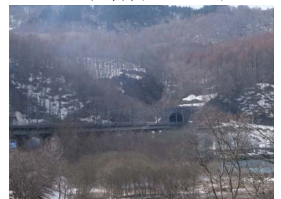
青函トンネル出入り口
