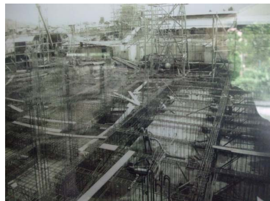
鉄筋工事の記録写真
