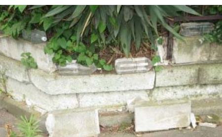
▲ 塀の崩れは「空家」のサインのひとつ
