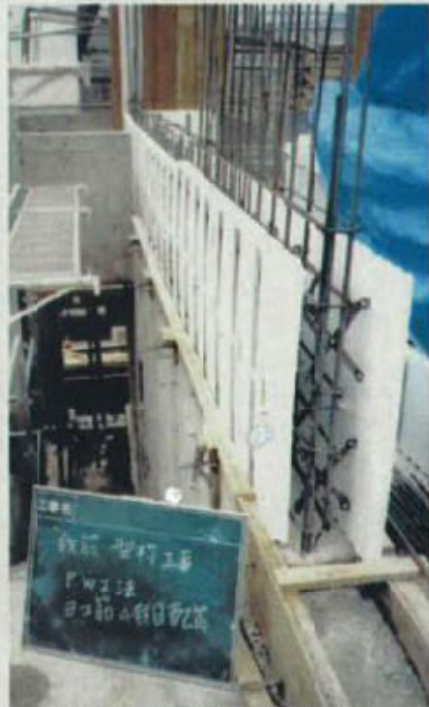
型枠兼用断熱材の施工現場。白い部分が型枠の発泡ポリスチレンで、断熱材となる(高知市内)
