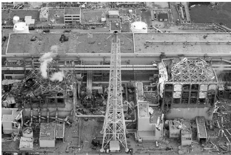
水素爆発で破壊された 3 号基と 4 号基
