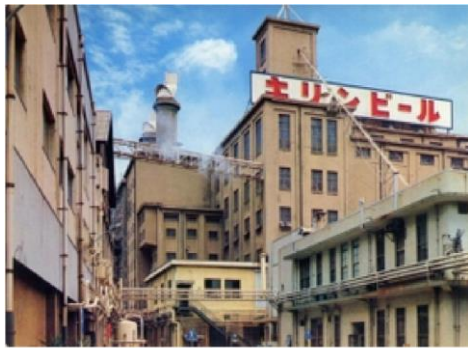
1970年代に撮影された「キリンビール尼崎工場」の外観 2020.5.13 神戸新聞
