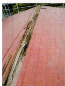
▲古い役物板金を取り外します。
