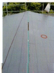
▲野地板に穴を開け、空気の通気口を作ります。
