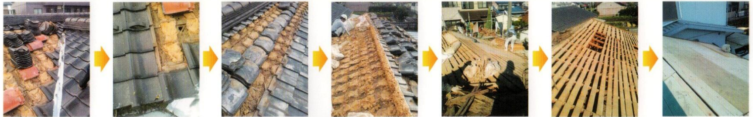
▲古い屋根瓦を慎重に剥がし、土や漆喰も取り除きます。
